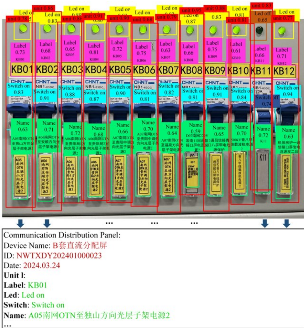
图12 配电屏数字化结果示意图
